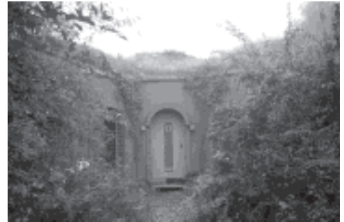
写真-5：土で覆われたアースシェルター／カッセル・エコロジー団地
