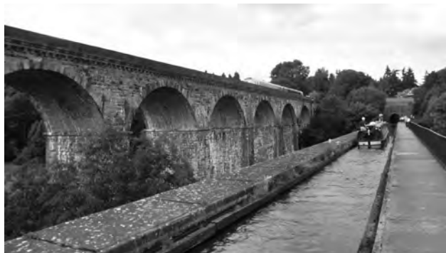
写真1 チャーク水路橋と鉄道橋 撮影：筆者
