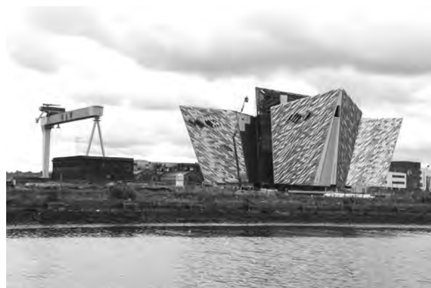
写真 2 建設中の「タイタニック・ベルファスト」記念館と H&W社のクレーン (根本撮影：2011 年 8 月 13 日)
