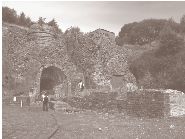
(左が第4溶鉱炉、右が第5溶鉱炉：藤田撮影 2011.8.17)
