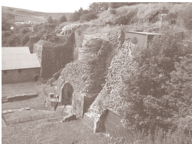
(上部に upper yard の一部が見える：藤田撮影 2011.8.17)
