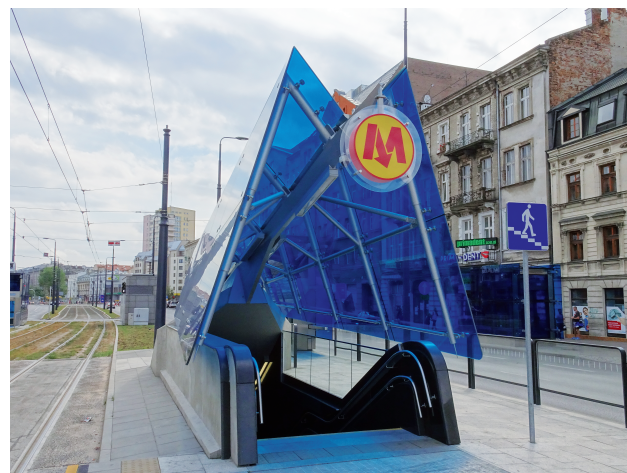
写真-35 地下鉄出口 (メトロのMのデザイン)
