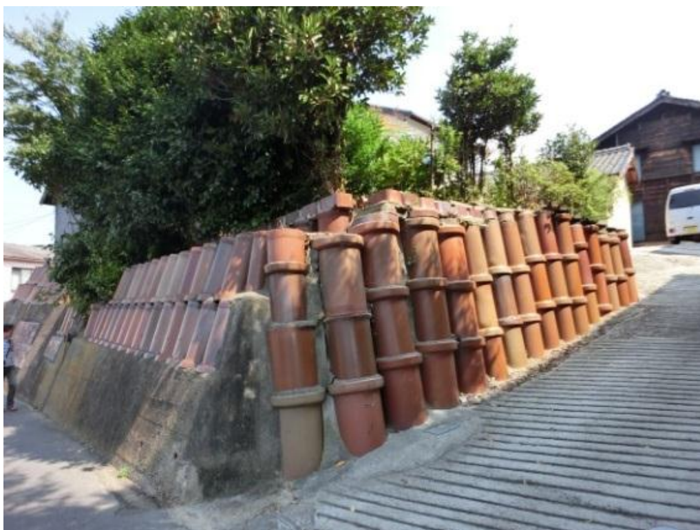
写真 3 土管の擁壁 (2015年9月22日筆者撮影)
