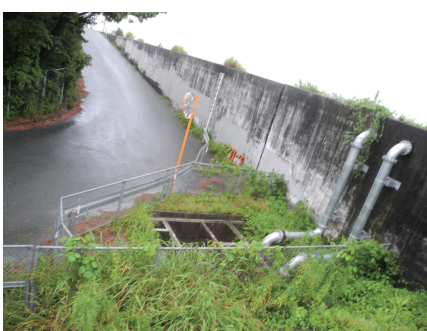
②表浜東駐車場への入口を抜けると勾配坂
