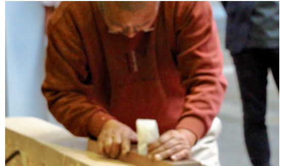
写真30 仕上げ鉋かけ
