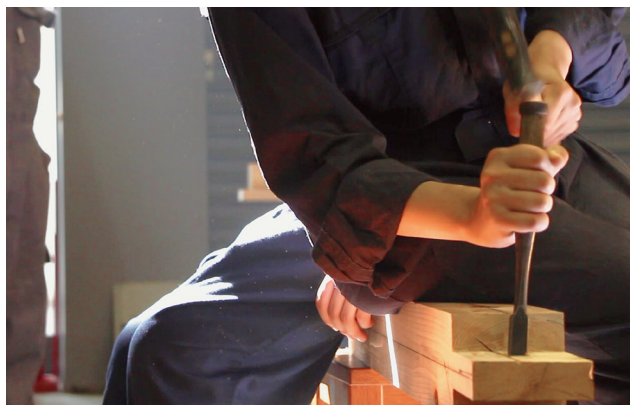
写真17 学生による鑿での加工
