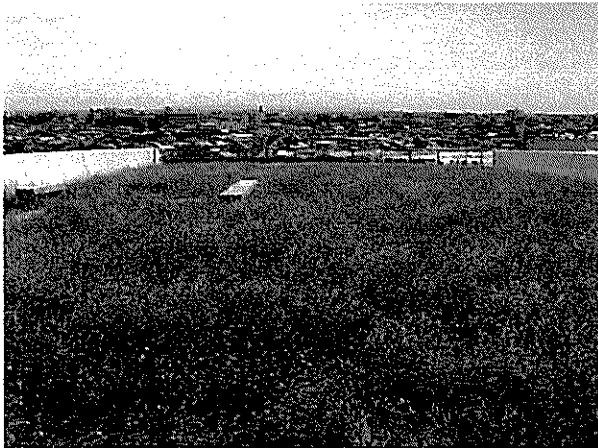
平成12年6月:北棟東ブロック
