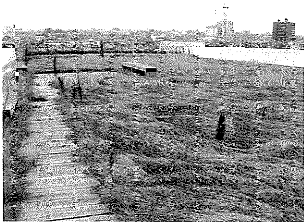
平成12年8月:北棟東ブロック
