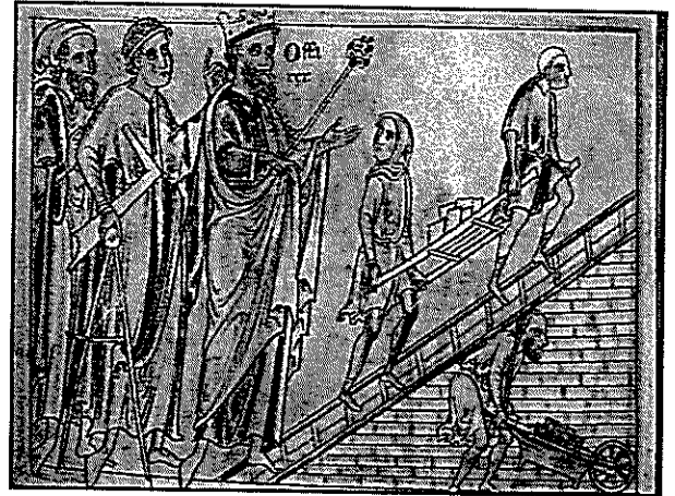
図 2-26 大聖堂の工事
