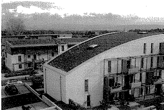
ドイツの extensive 緑化(カッセル)
