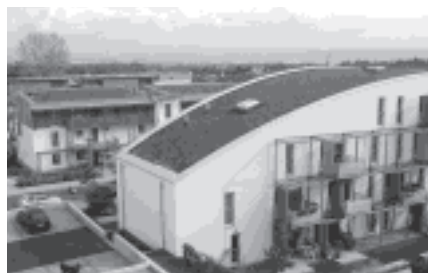
写真3：マルパッサシヨンのパッシブ住宅団地／カッセル
