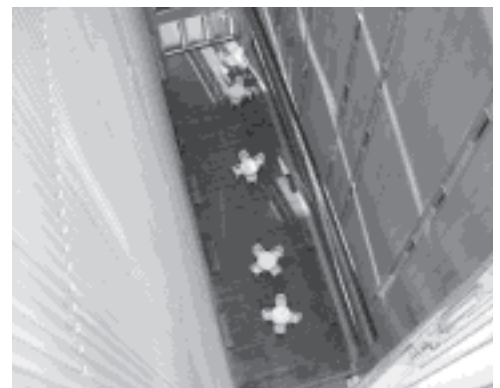
図 6. 研究室棟3階テラス
