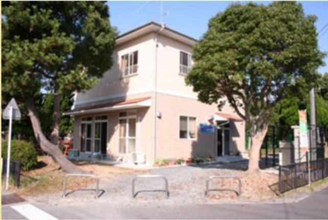
多文化交流センターの外観
